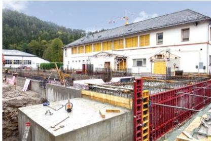
Foto 1: [Betonieren der Bodenplatte für das Internat 1](#)
