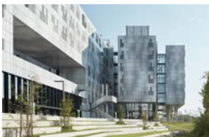
2012–2017 MED CAMPUS Graz Modul 1 Neubau
