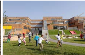
2013–2017 Bildungscampus und -quartier Aspern, Wien Neubauten
