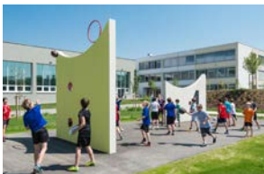
2013–2015 BRG Kramszeile, Krams an der Donau Sanierung und Erweiterung
